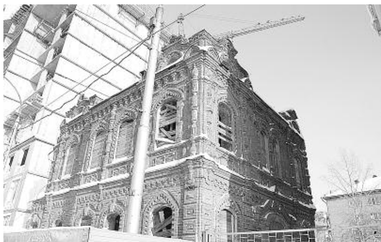
Дом около Центрального парка (полуразрушенный).
